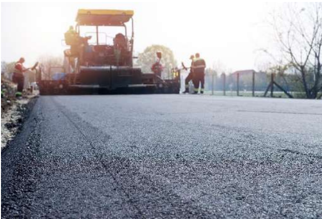
Gambar 8.1. Perbaikan jalan sebagai salah satu upaya pembangunan infrastruktur
